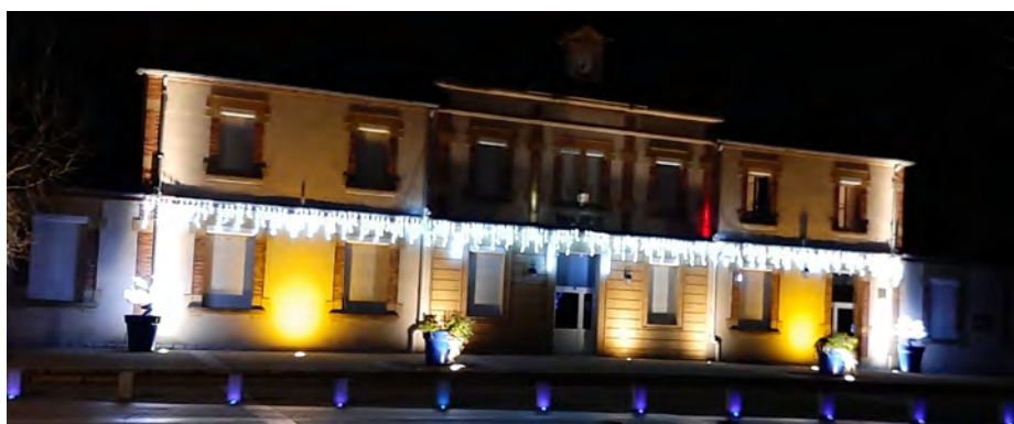
Illuminations de Noël sur les murs de la mairie.
