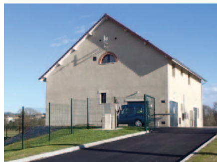
Nouvelle usine de traitement et de production d'eau potable de Port Saint Augin, commune de Dompierre-sur-Besbre mise en service en octobre 2014.
