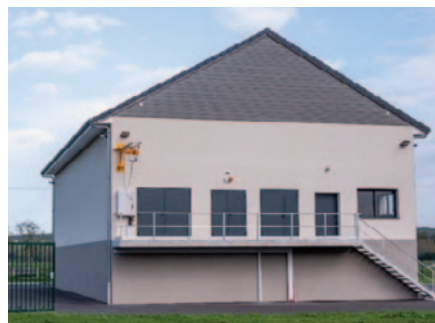
Nouvelle usine de traitement et de production d'eau potable des Monins, commune de Coulanges mise en service en mai 2022.
