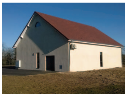
Nouvelle usine de traitement et de production d'eau potable de Picuze, commune de Dompierre-sur-Besbre mise en service en novembre 2016.
